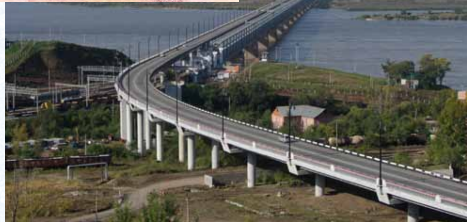
4-е место. Мост через реку Амур в г. Хабаровске
