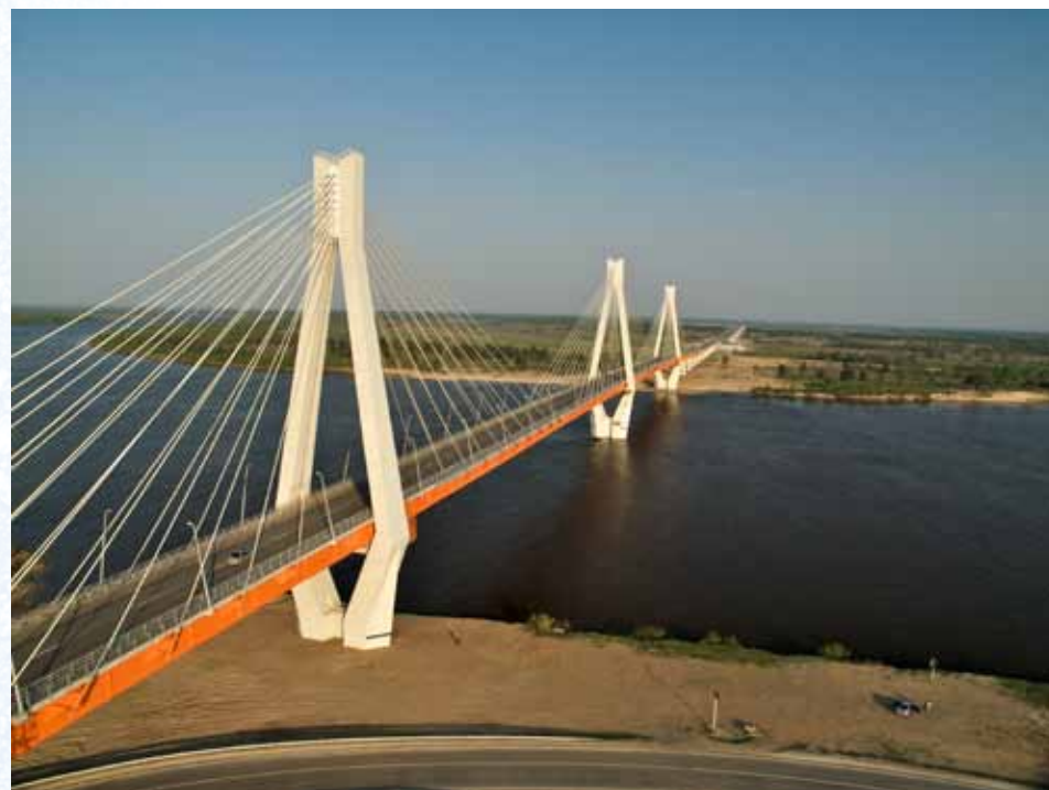
1-е место. Мост через реку Оку на обходе г. Муром
