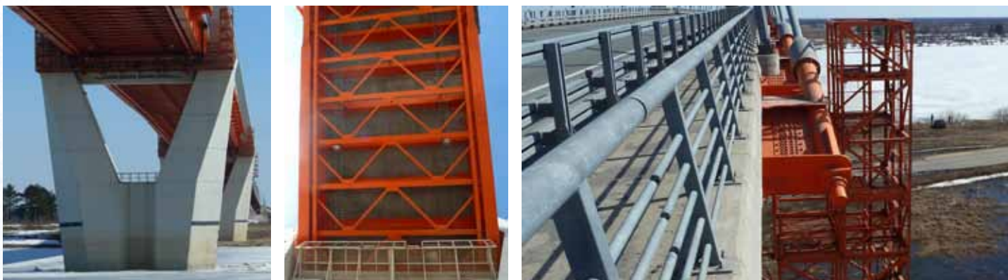
Рис. 2. Пример полного обеспечения смотровыми приспособлениями балки жесткости вантового моста через Оку на обходе г. Муром
