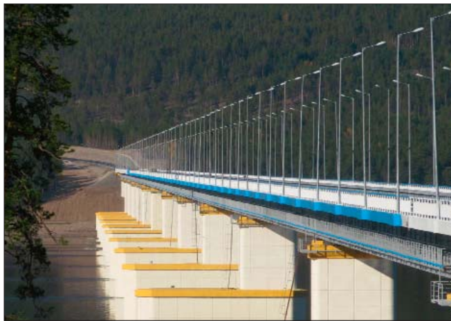
Рис.4. Мост через Ангару у села Богучаны на автодороге Богучаны – Юрубчен – Байкит, запроектированный ОАО «Трансмост», оснащен развитой системой эксплуатационных обустройств
