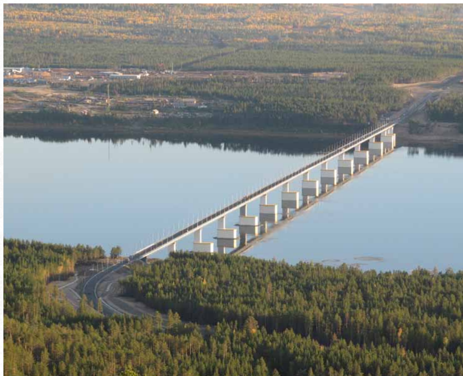
Рис. 1. Мост построен с перспективой на развитие железнодорожной составляющей
