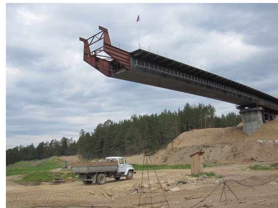
Рис. 3. Монтаж пролетного строения с правого берега
