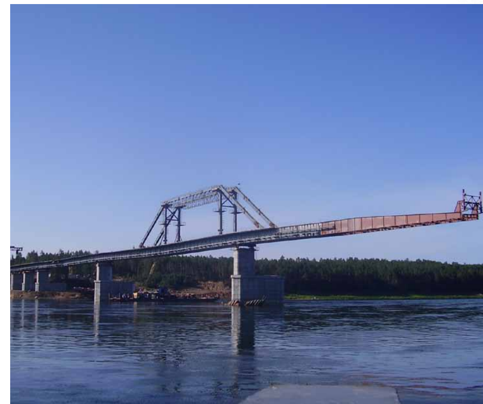
Рис. 2. Монтаж пролетного строения с левого берега
