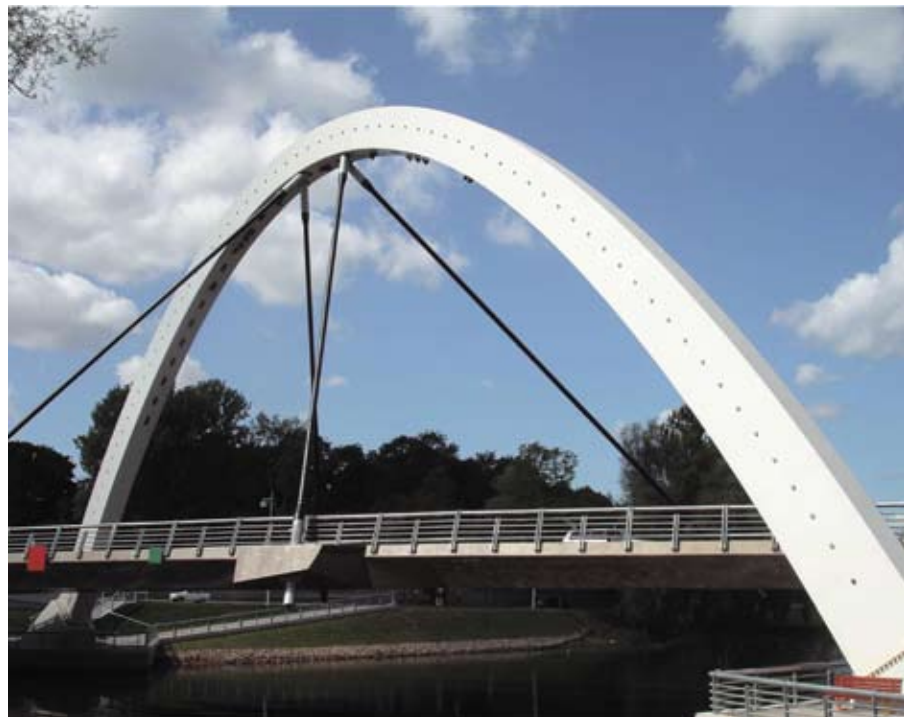
Вантовый мост в г. Тарту с арочным пилоном
