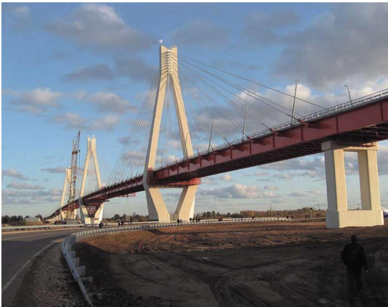
Мост через р. Оку в Муроме
