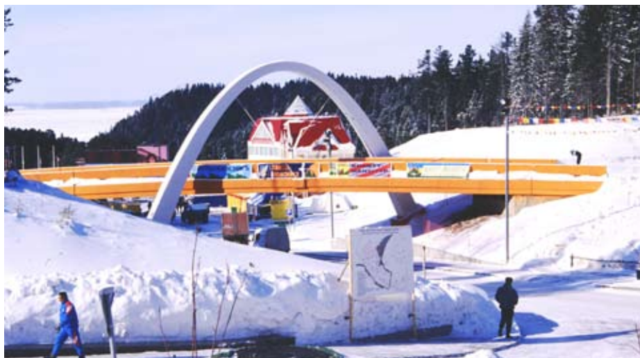
Мост на лыжероллерной трассе в г. Ханты-Мансийске
