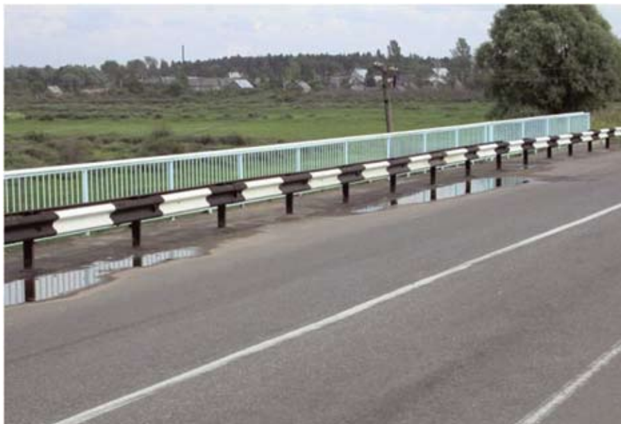
Рис. 1. Застой воды в средней части имеющих провисание балочных пролетных строений, при среднем проектном продольном уклоне 15‰
