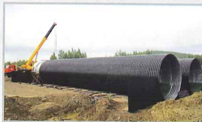
РЕКОНСТРУКЦИЯ АВТОДОРОГИ М-56 «ЛЕНА» НЕВЕР-ЯКУТСК 93 КМ – 123 КМ АМУРСКАЯ ОБЛ.
