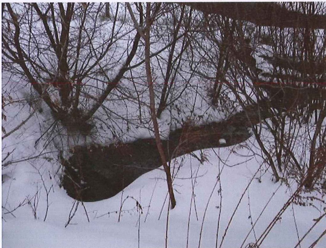
Фото 1 – ПК 17. Выход р. Рахмы из коллектора
